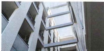
介護職の動線をできるだけ短くする狙いから建物を分節化。構造上の安全性を確保しようと、建物同士を梁で接合した。1階部分は鉄筋コンクリートだが、2階以上はLVL(単板積層材)と呼ばれる木材。ただし、コンクリートに見える外装材で仕上げた。
